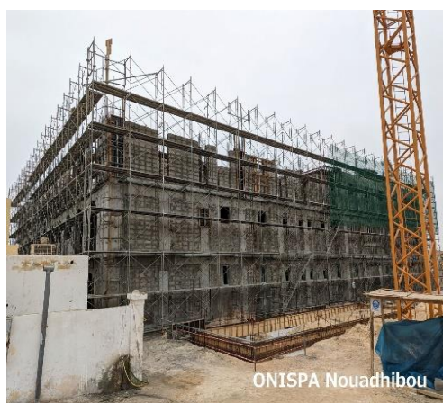
工事中の ONISPA ヌアディブ検査・分析所
